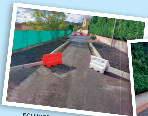
ECLUSES POUR RALENTIR LA VITESSE CHEMIN DES CITES ET CHEMIN DE JALAVOUX
