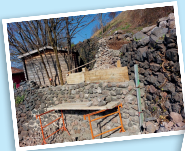
RECONSTRUCTION DU MUR QUI LONGE LE CHEMIN DU GARAMPOU REALISATION PAR NOS AGENTS TECHNIQUES
