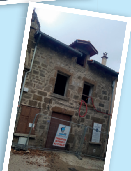
MAISON RUE DU ROCHER : début des travaux extension Espace St-Michel.
