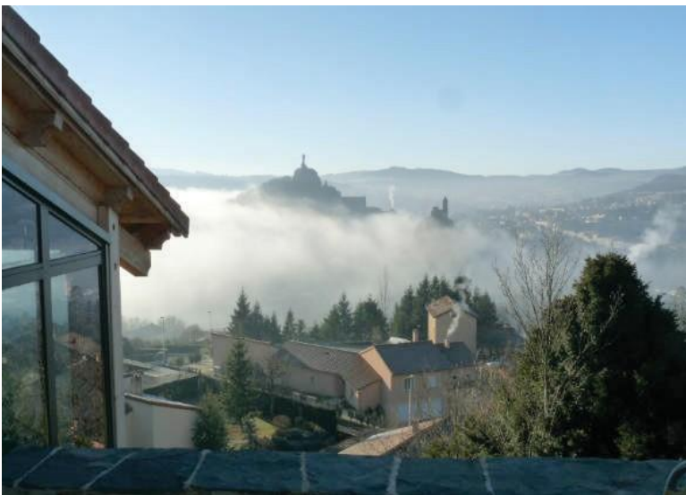
Mise en scène des éléments architecturaux depuis le coteau
