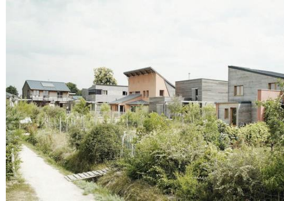
Constructions mitoyennes (Bazouges-sous-Hédé-35)
