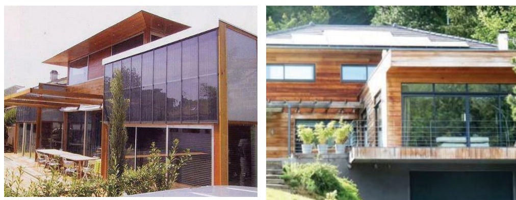
Résonance entre panneaux solaire et architecture
