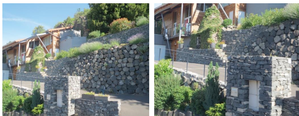
Coffrets et boîte aux lettres encastés dans un élément architectural (Aiguilhe)
